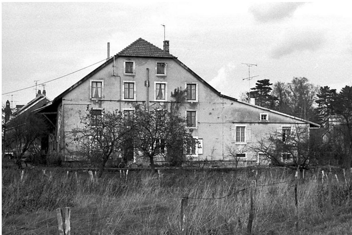
Vue du pignon droit de l'habitation.
