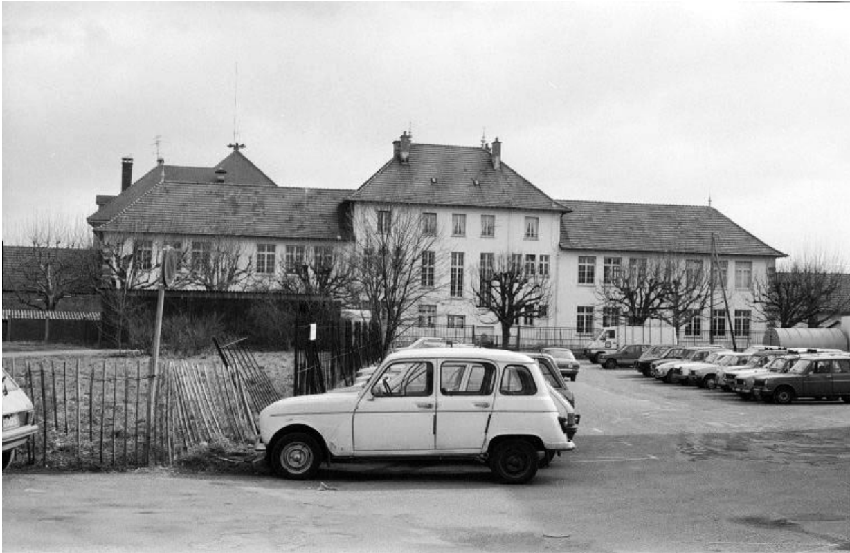
Façade postérieure sur cour.
