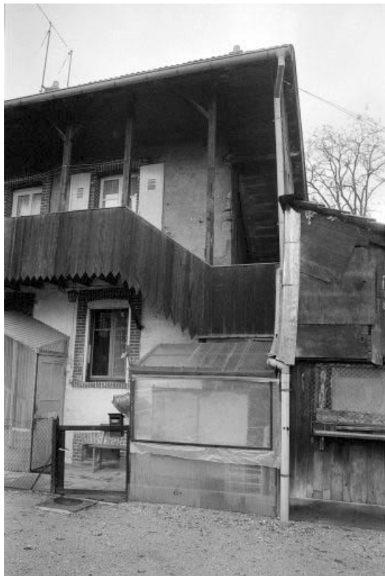
Façade postérieure : détail.
