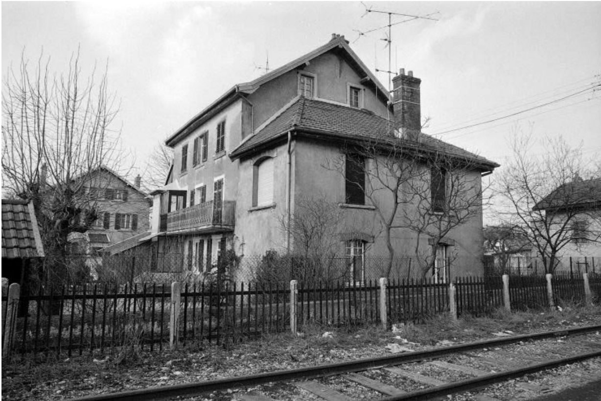
Façades antérieure et latérale gauche.
