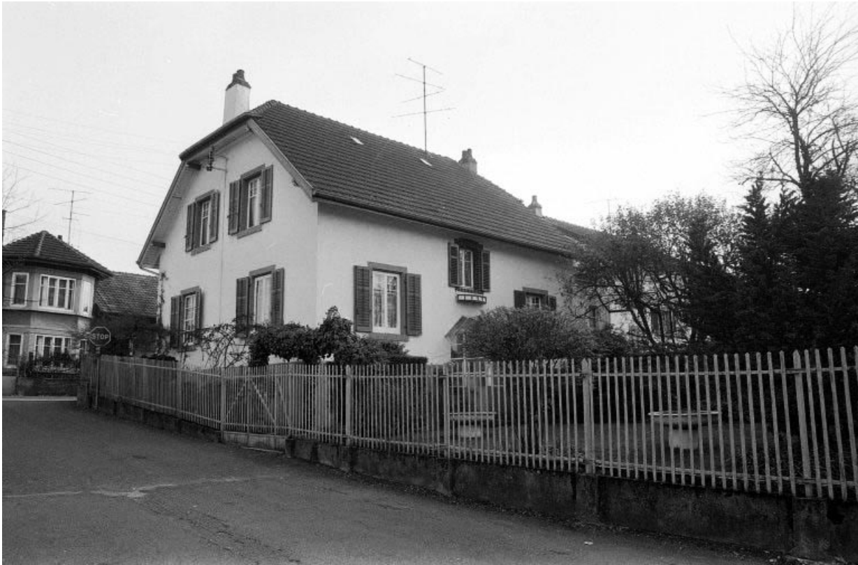
Façades postérieure et latérale droite.
