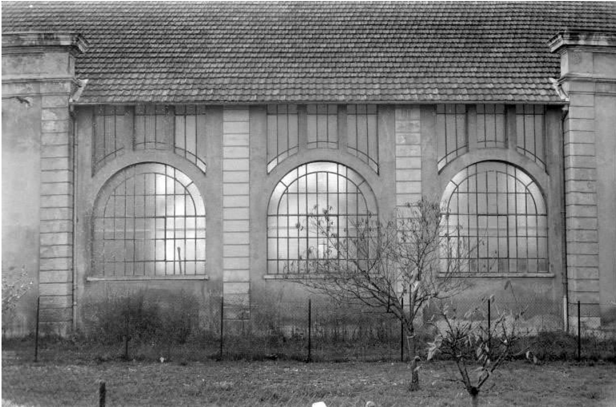
Baies sur la façade latérale droite.
