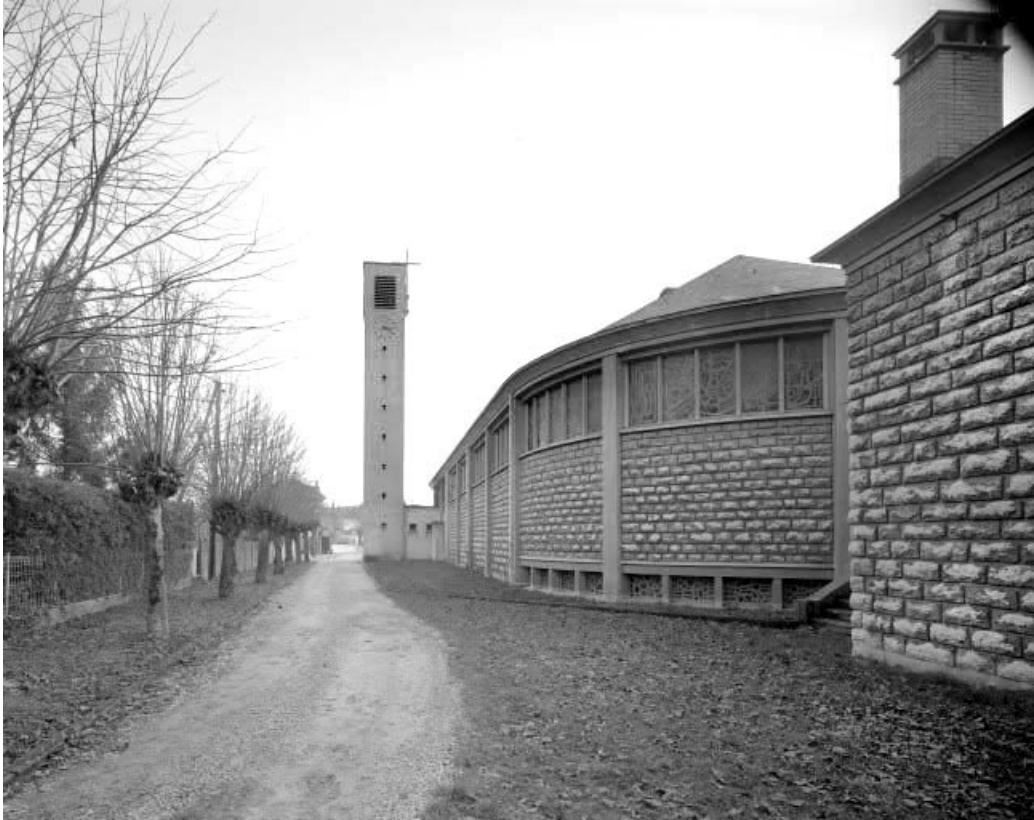
Façade latérale droite.
