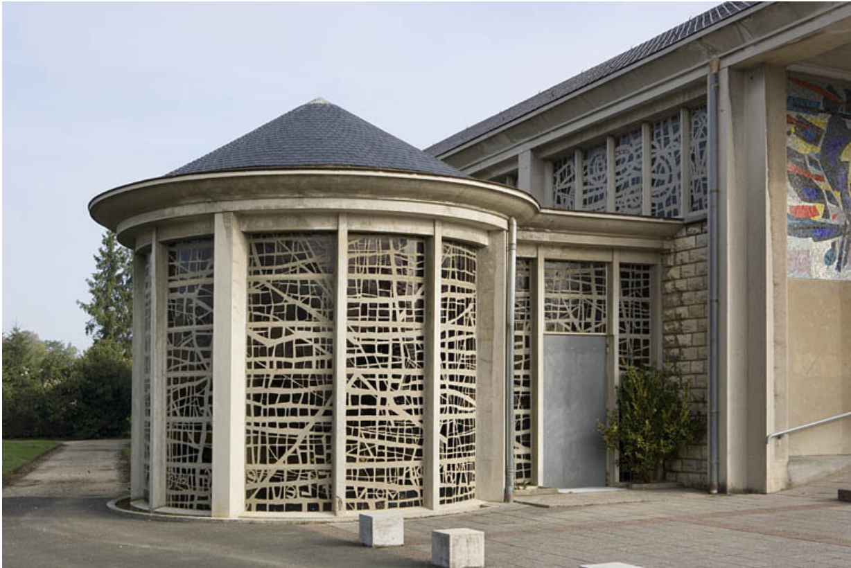
Vue extérieure du baptistère.
