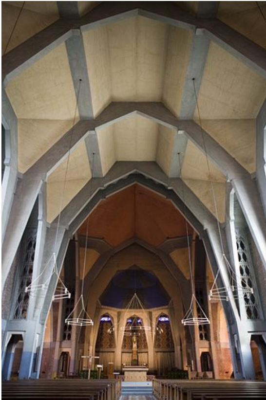
Plafond de la nef.
