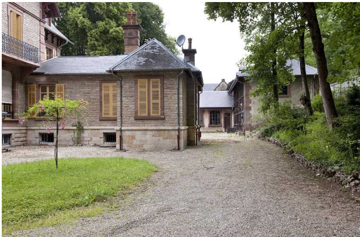
Façade sud de l'annexe et communs.
