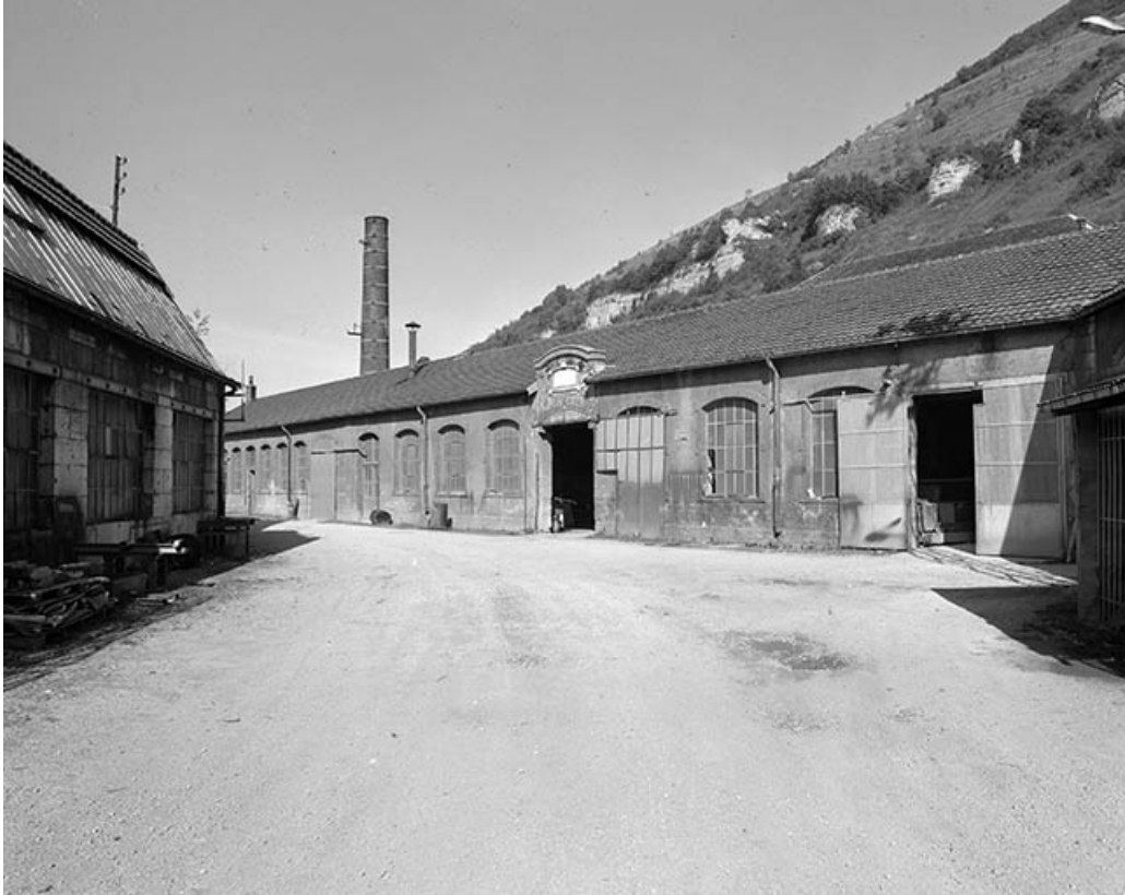
Façade antérieure de la clouterie.
