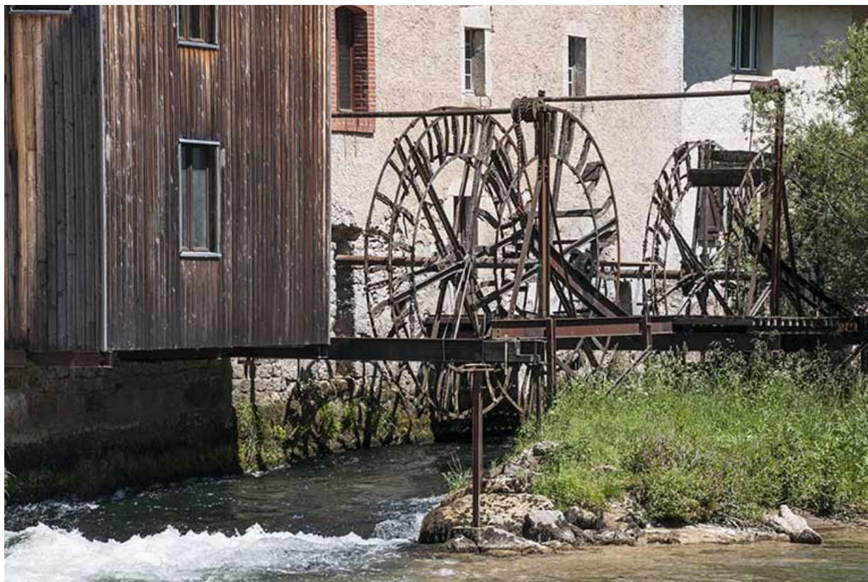
Roues hydrauliques depuis l'aval.
