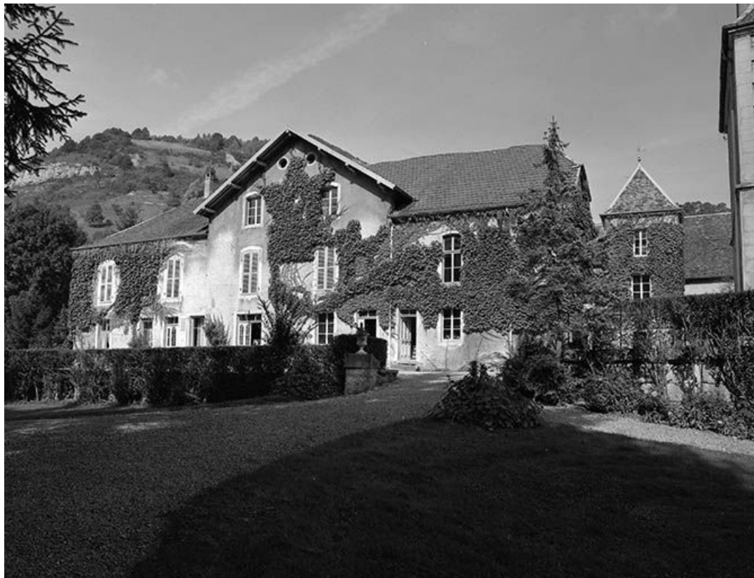
Façade antérieure du logement du gardien.
