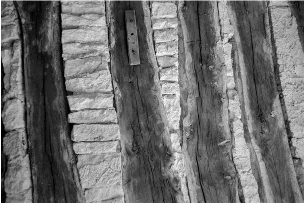
Intérieur des parties agricoles : le plafond.
