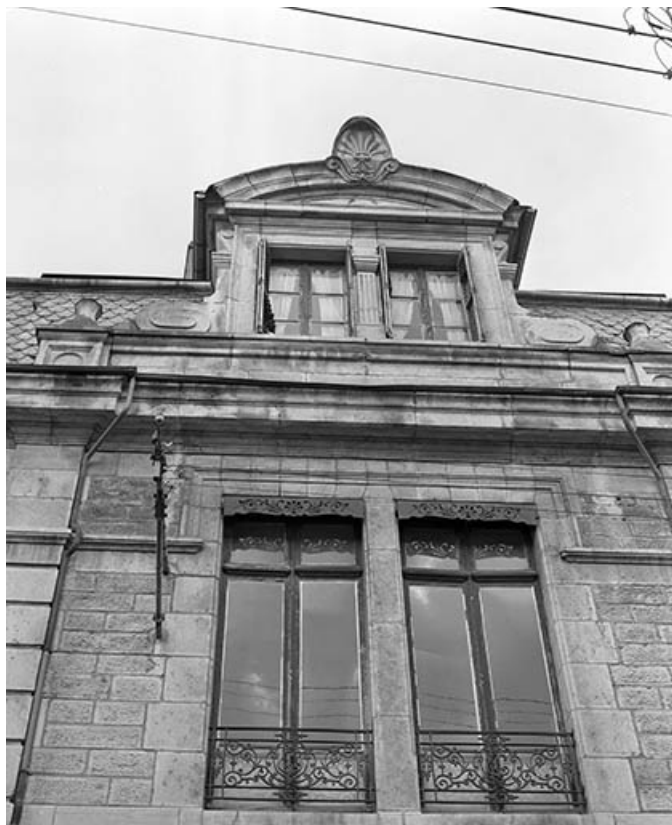
Façade antérieure, détail de la travée centrale.
