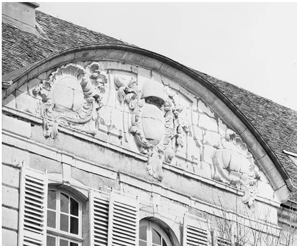
Façade antérieure : le fronton.
