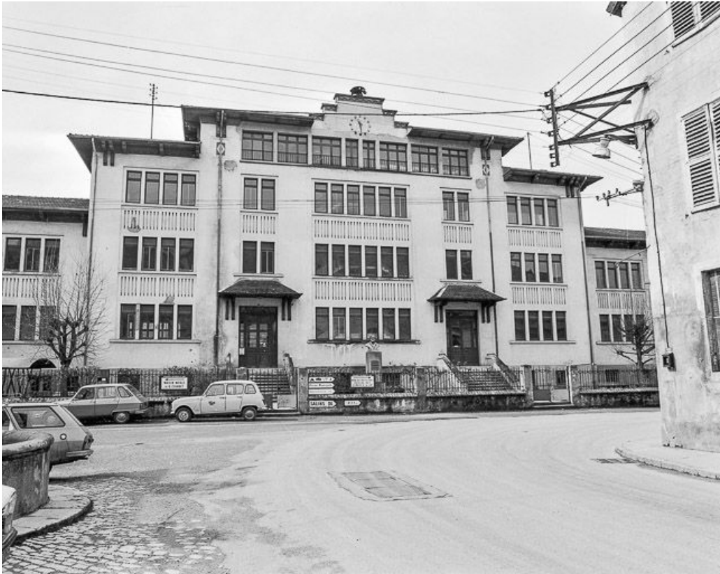
Vue d'ensemble (bâtiment détruit).
