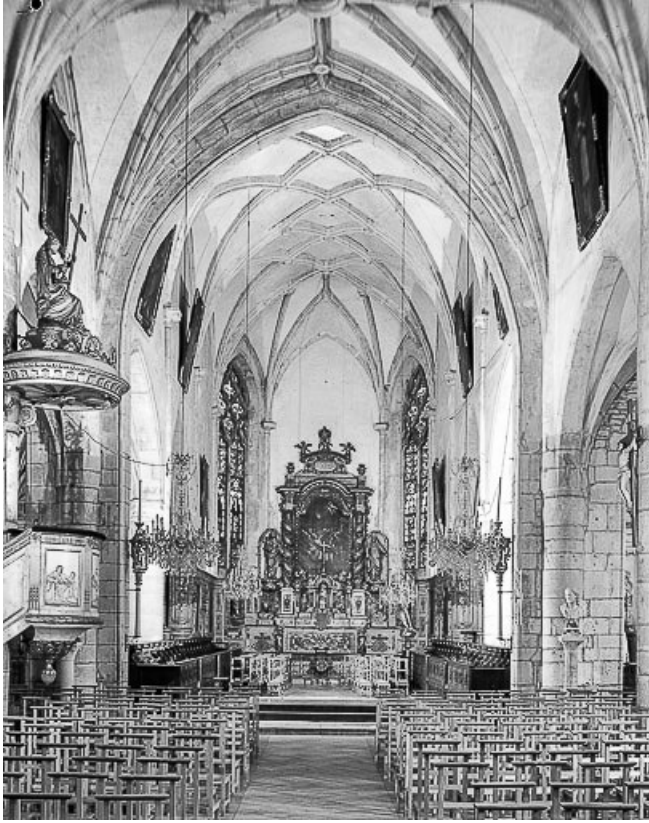
Intérieur : le chœur vu depuis la nef.
