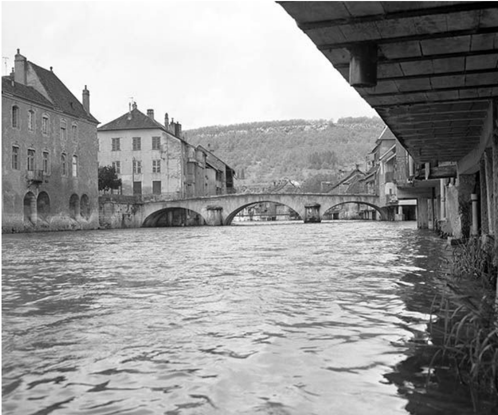
Vue générale depuis la rive droite.
