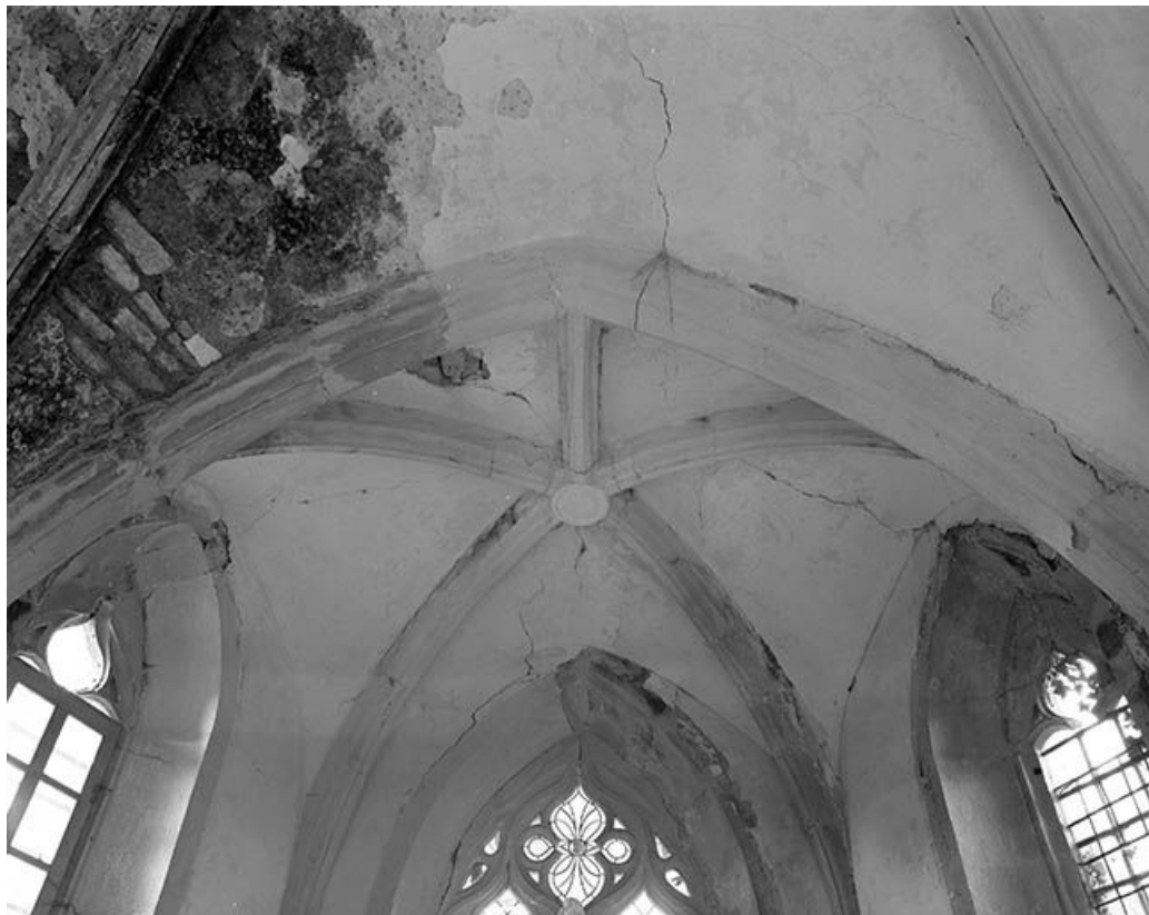
Intérieur de la chapelle : voûte du choeur.
