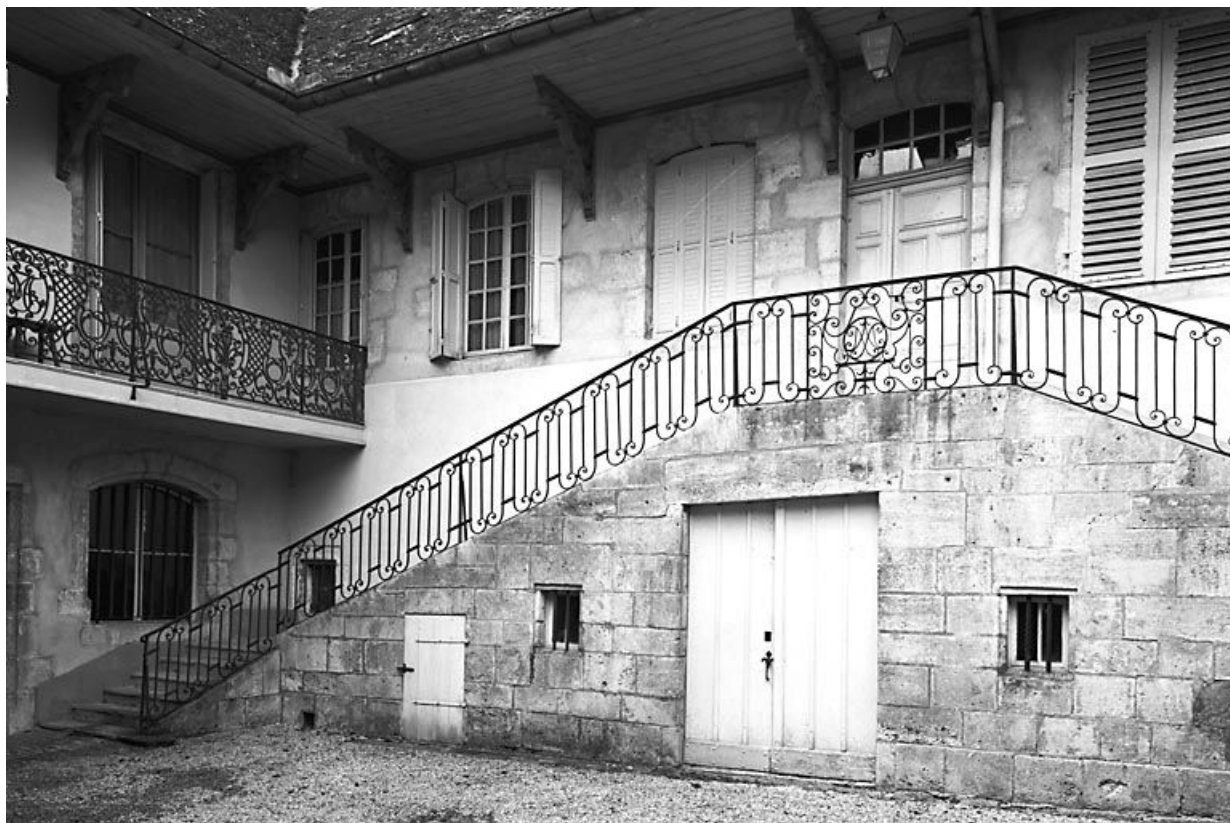
Escalier extérieur sur cour.
