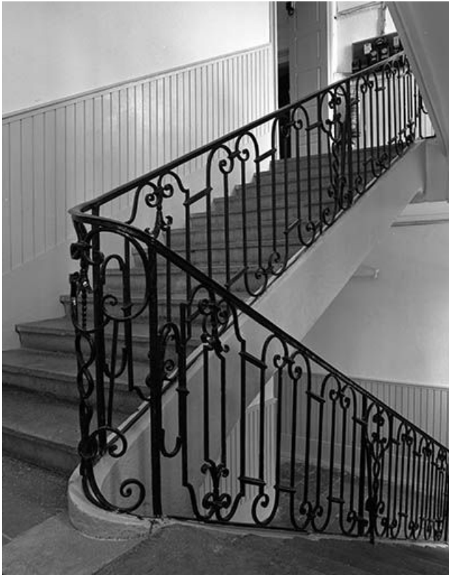
Intérieur, escalier : 2ème volée.
