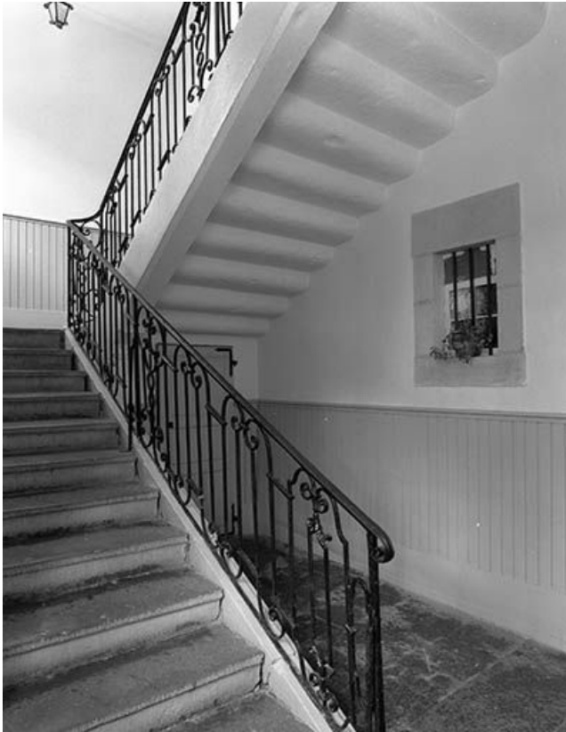
Intérieur, escalier : 1ère volée.
