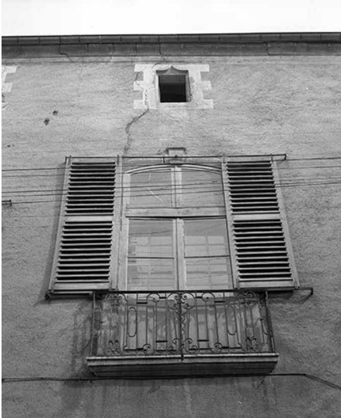
Face latérale gauche, détail d'une travée.
