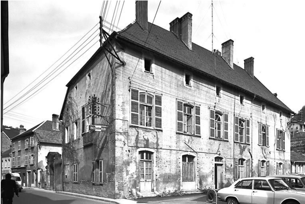
Façade antérieure et façade latérale gauche.
