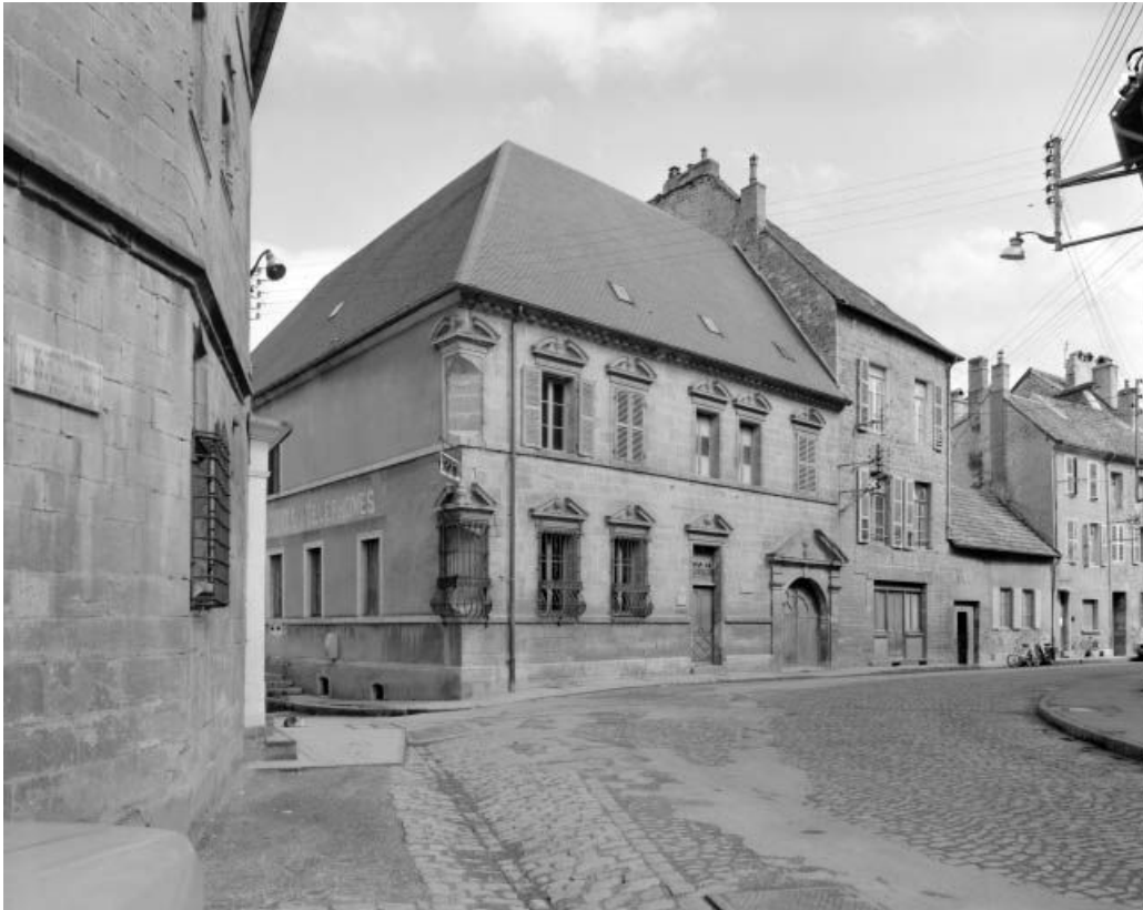
Façade antérieure et façade latérale gauche.
