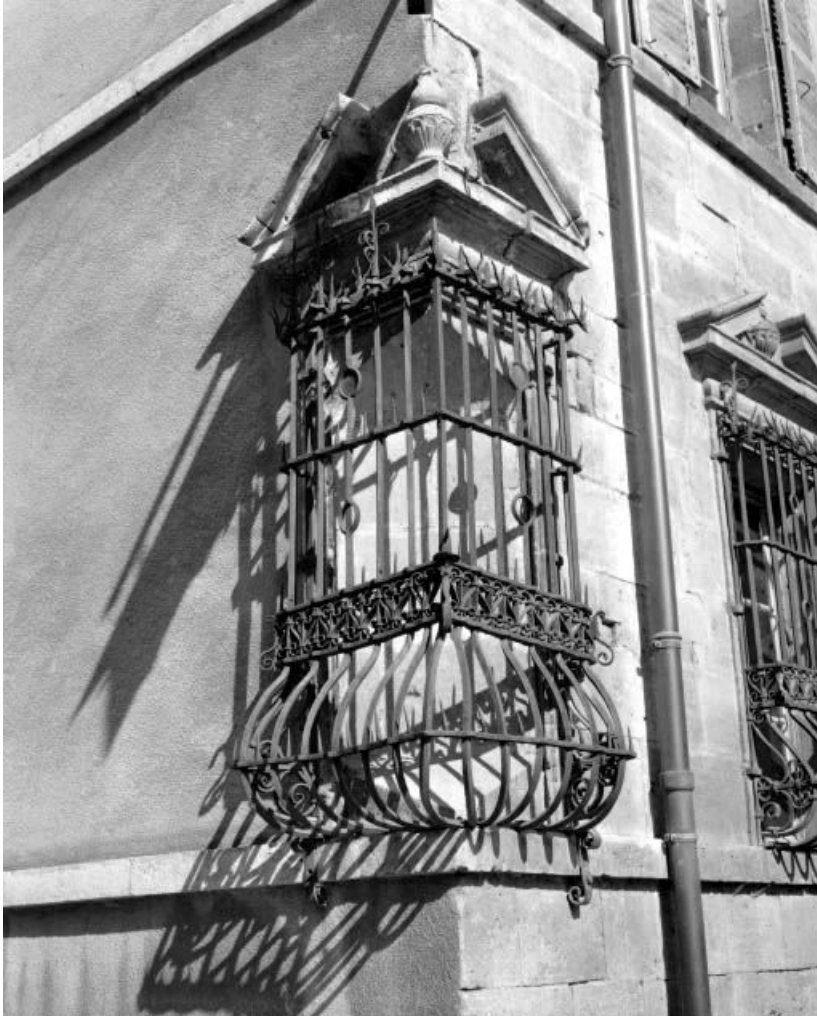
Façade antérieure, détail : baie d'angle du rez-de-chaussée.
