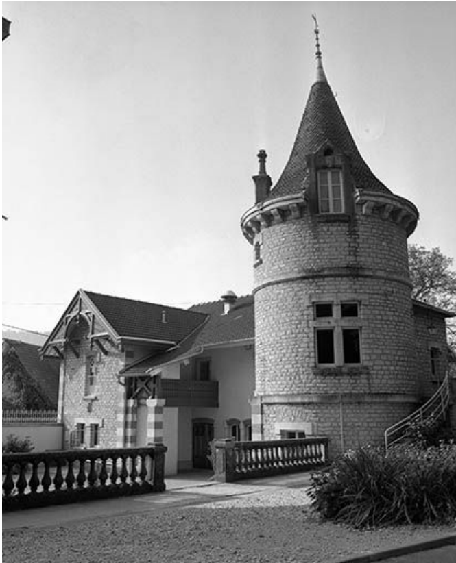
Façade antérieure des communs.
