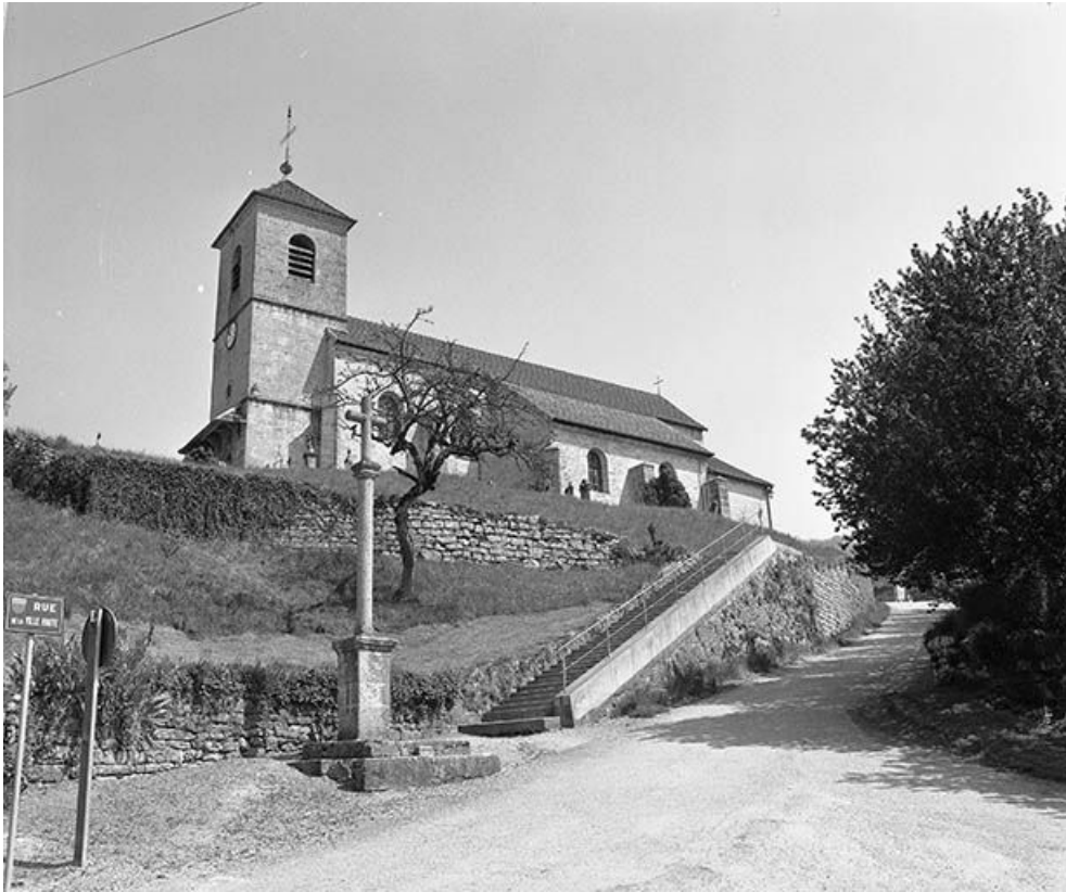
Façade antérieure et face latérale droite.
