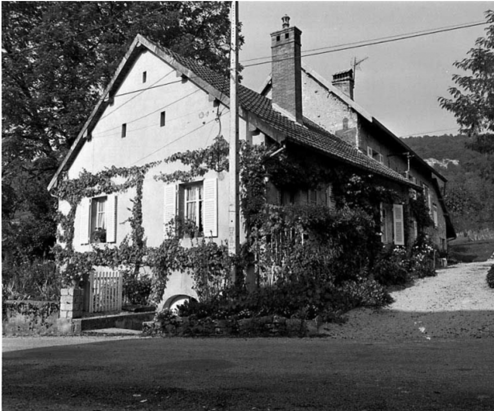
Façade antérieure et face latérale gauche. 25, Montgesoye
