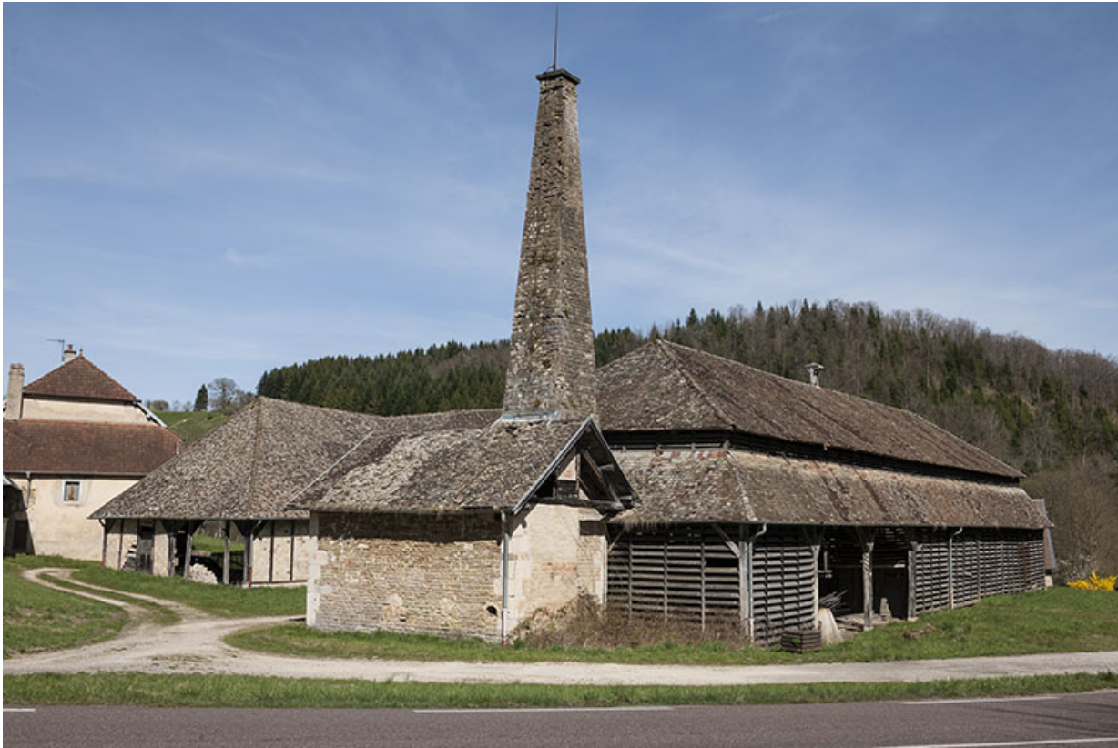
Vue rapprochée depuis le sud-ouest.
