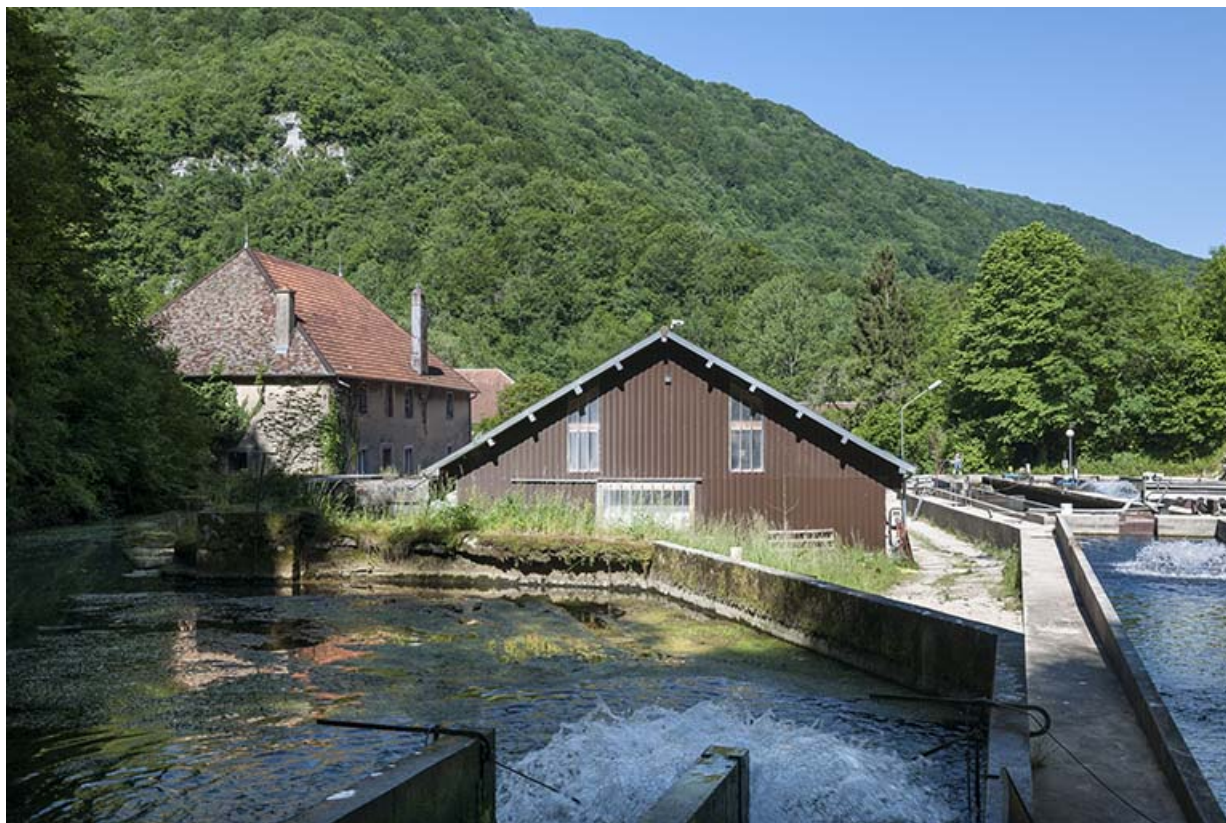
Vue depuis l'emplacement du bassin de retenue.
