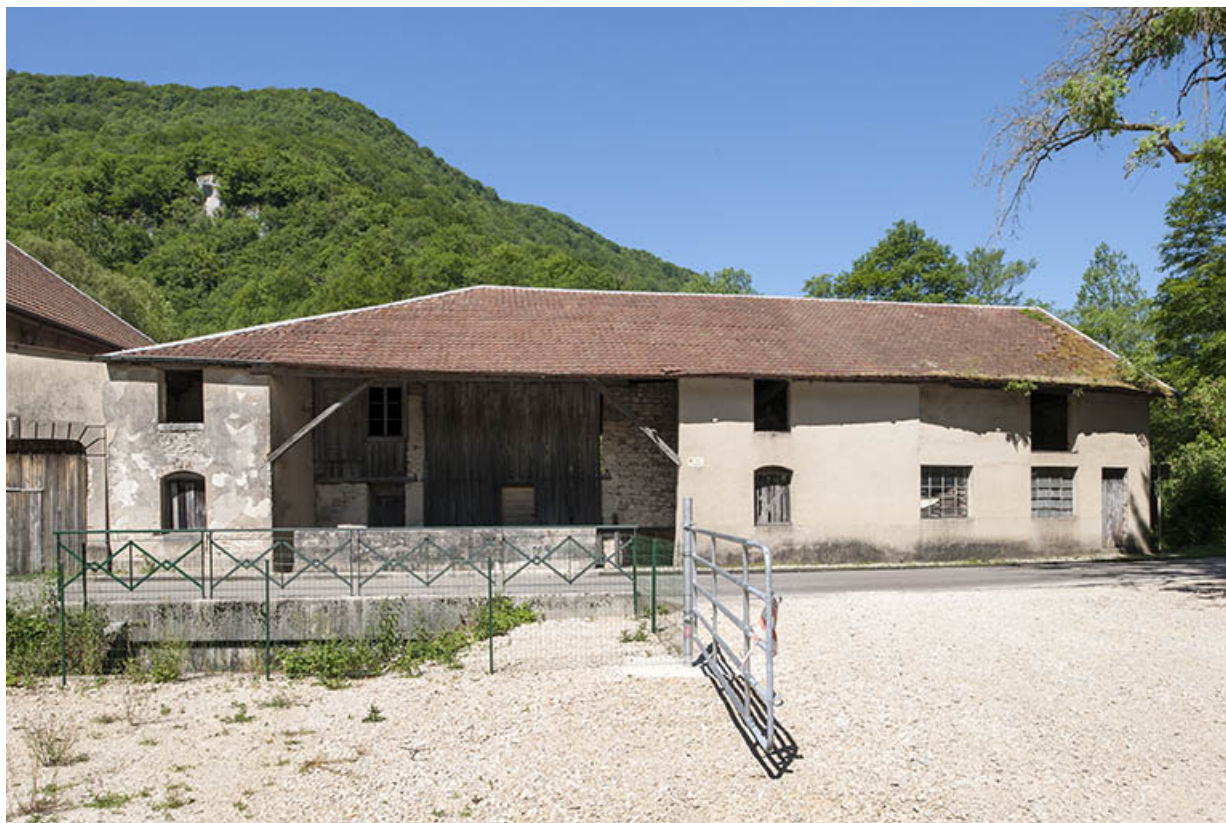
Façade est des écuries et remises.
