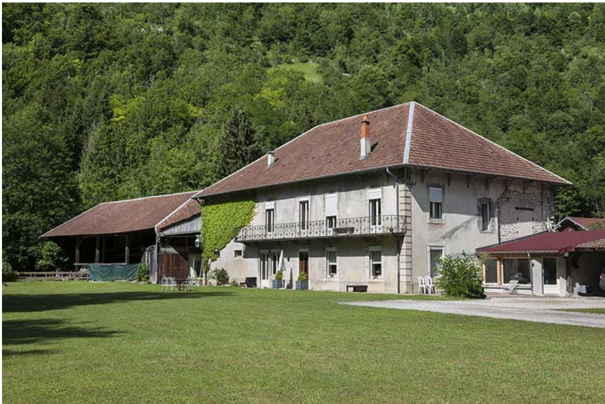
Logement patronal vu de trois quarts droite.
