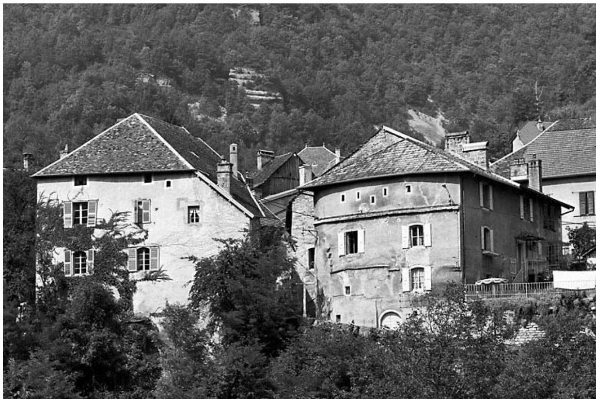
Elévation depuis le sud.
