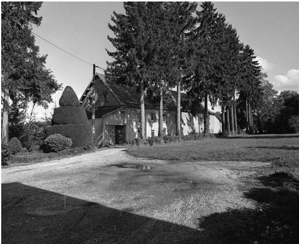
Vue générale des communs.
