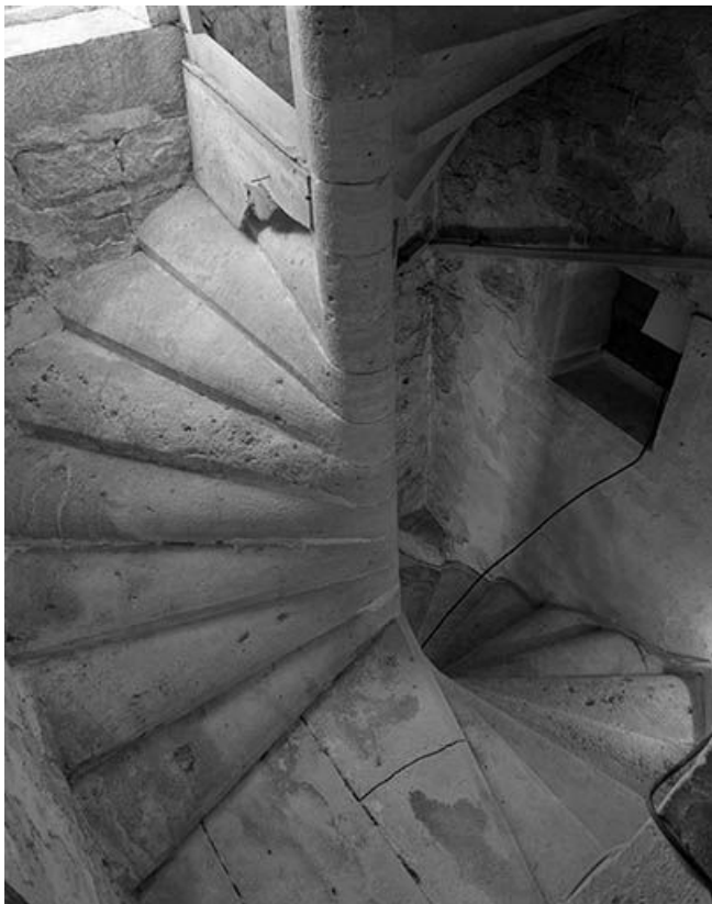
Intérieur : l'escalier en vis.
