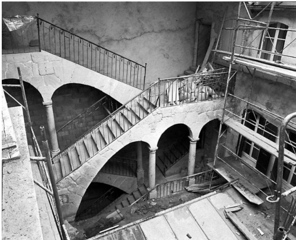
Escalier sur cour intérieure.
