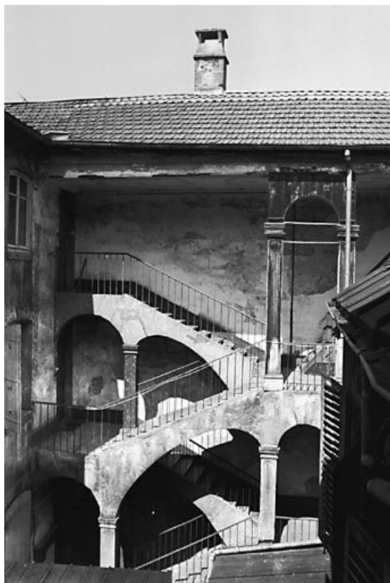
Escalier sur cour intérieure.
