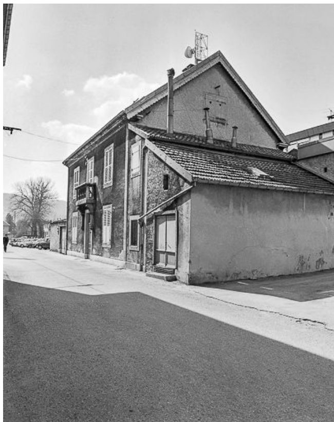
Façades sur rue et latérale droite.
