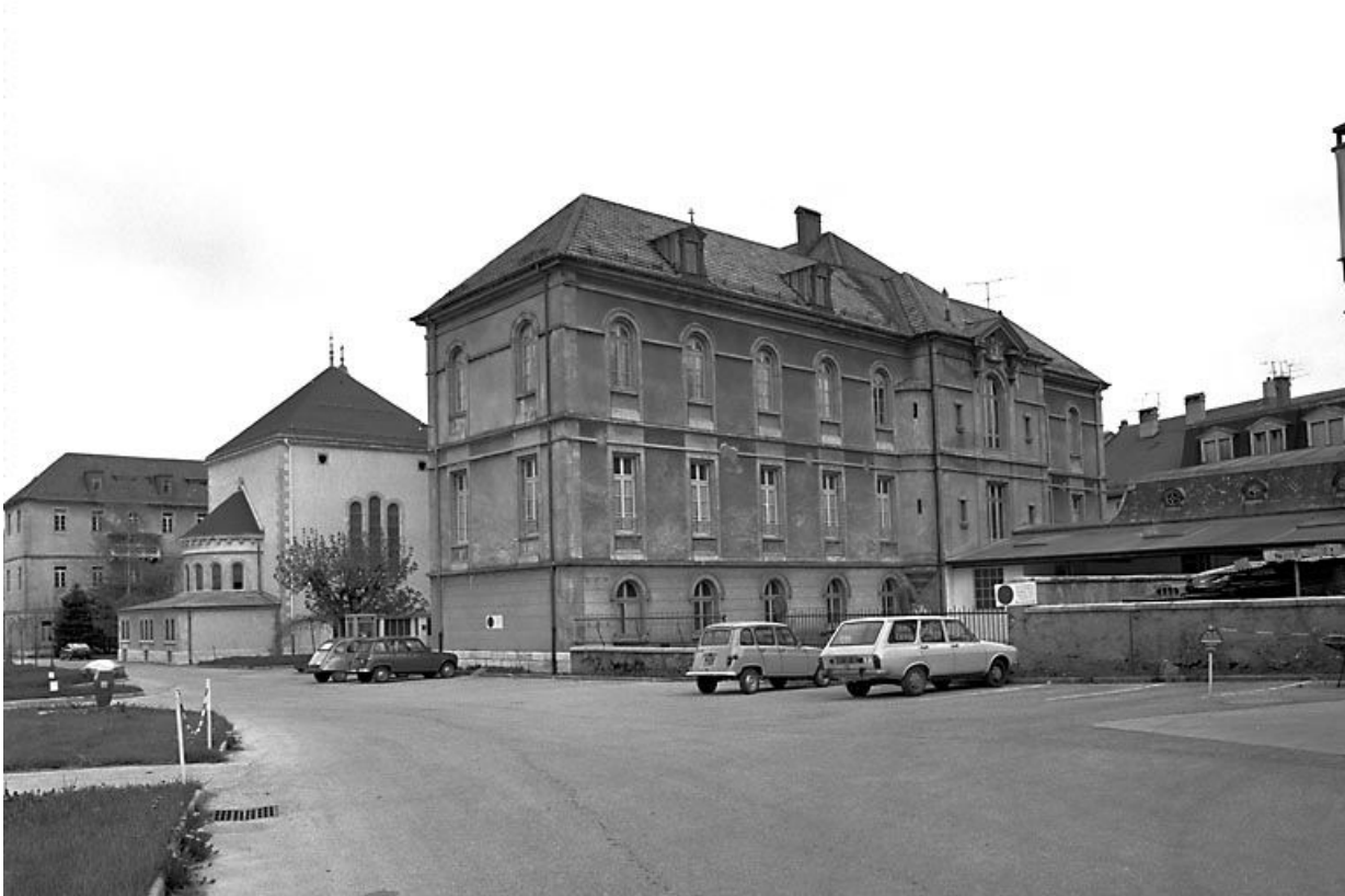
Façade postérieure, vue d'ensemble de trois quarts.
