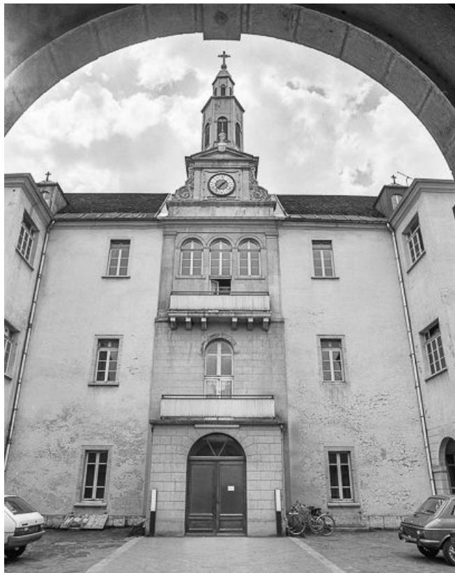
L'entrée, vue de face.
