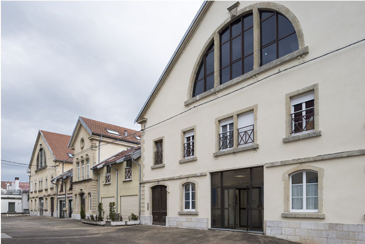
Façade ouest des chais et entrepôts.
