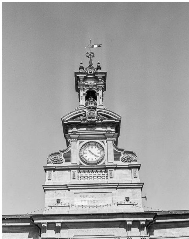
Partie supérieure, vue de face.
