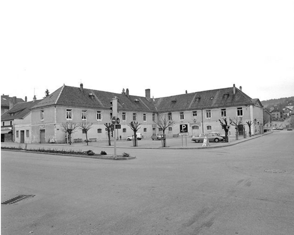
Corps de bâtiment gauche.
