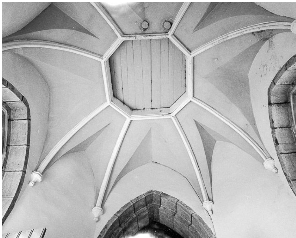
La voûte sous le clocher.
