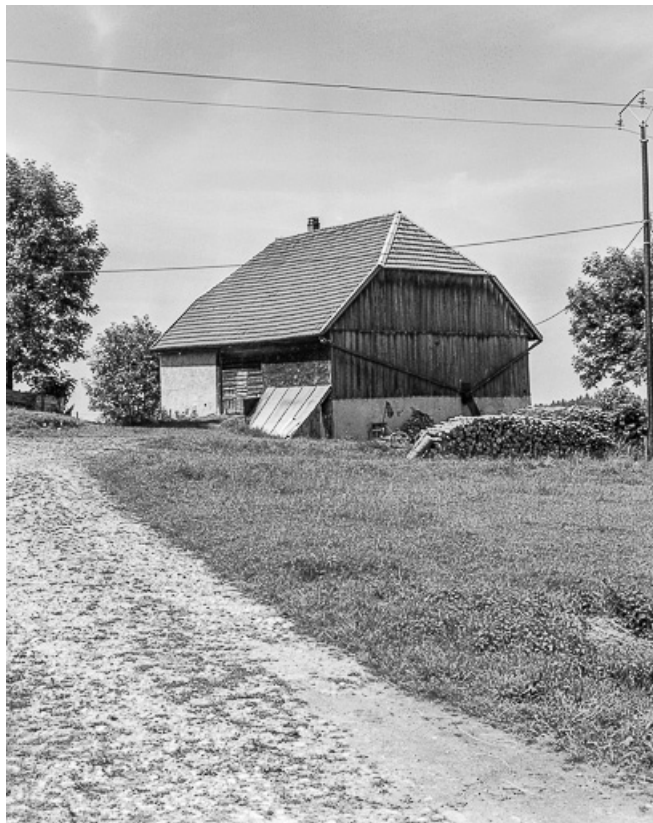
Façades postérieure et latérale droite.
