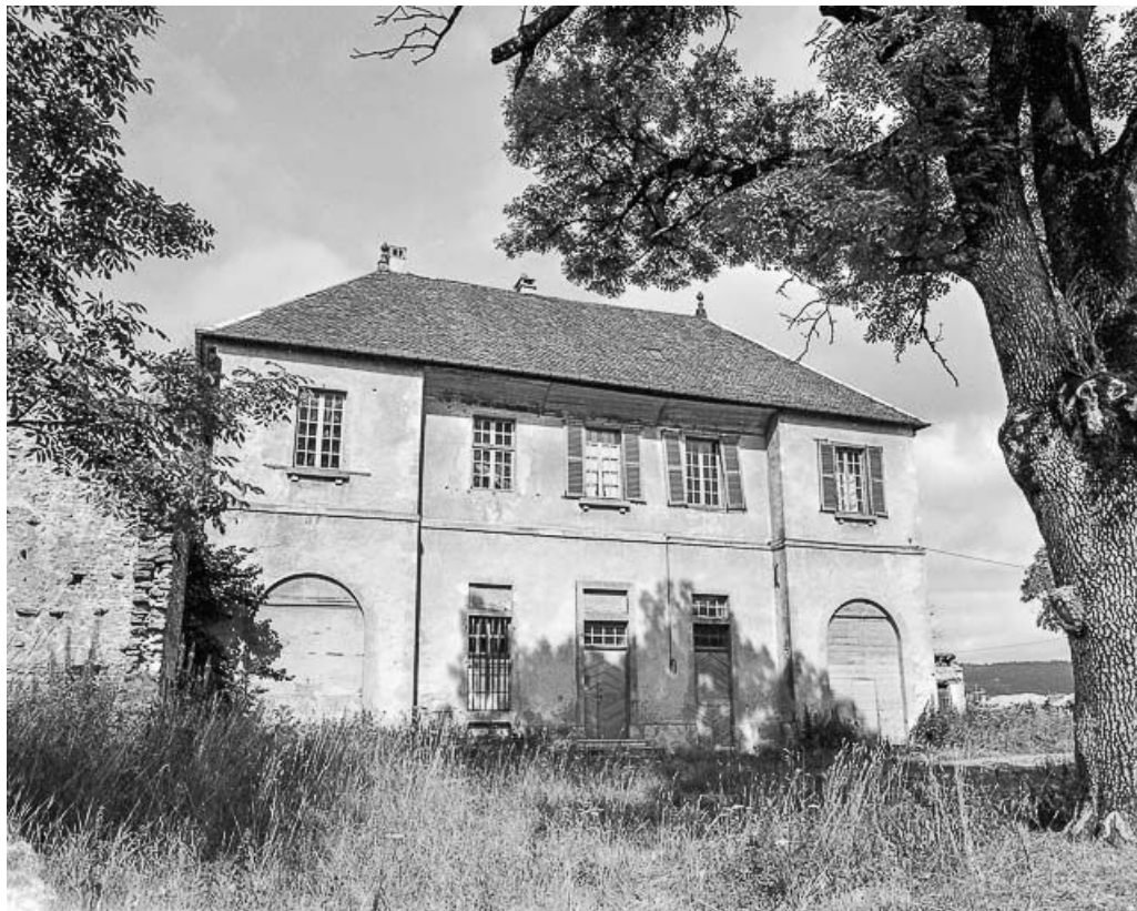
Façade sur rue. Vue de face.
