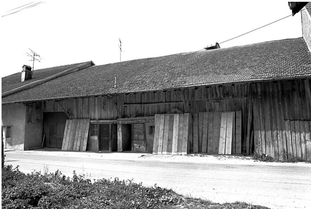
Façades sur rue.
