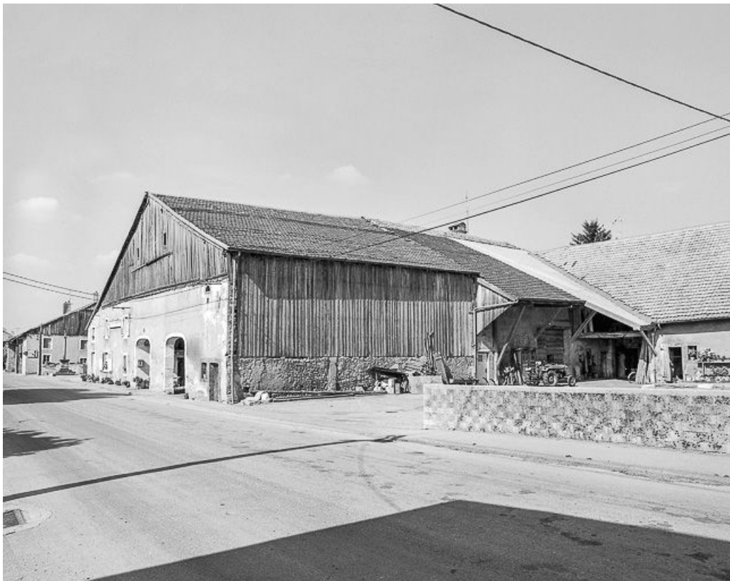
Façades antérieure et latérale droite.
