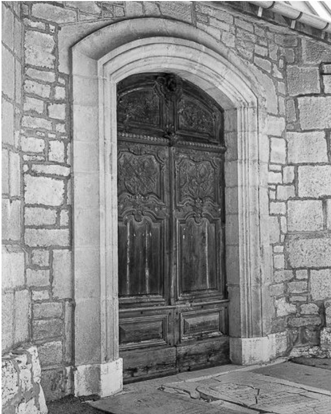
Vue d'ensemble de la première porte d'entrée.
