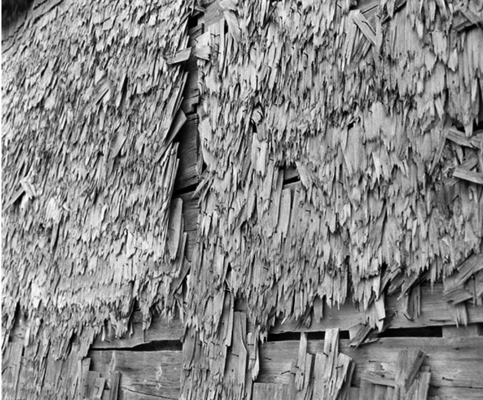
Tavillons de la façade latérale droite.
