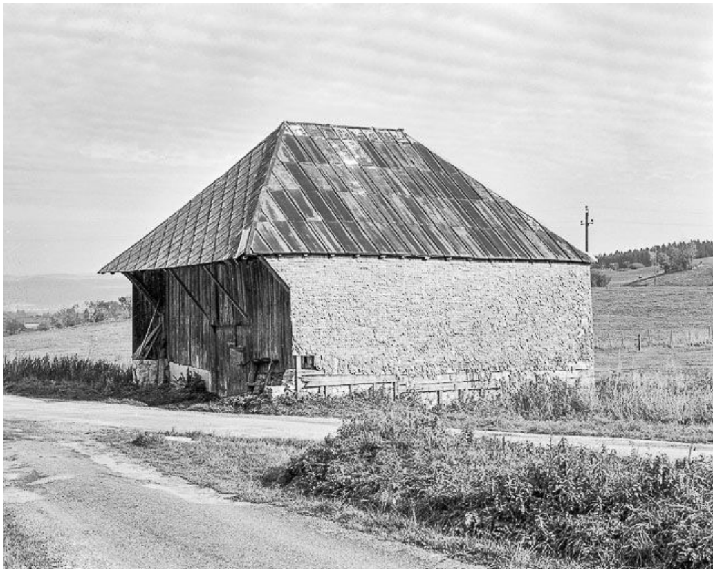
Bâtiment servant de remise.
