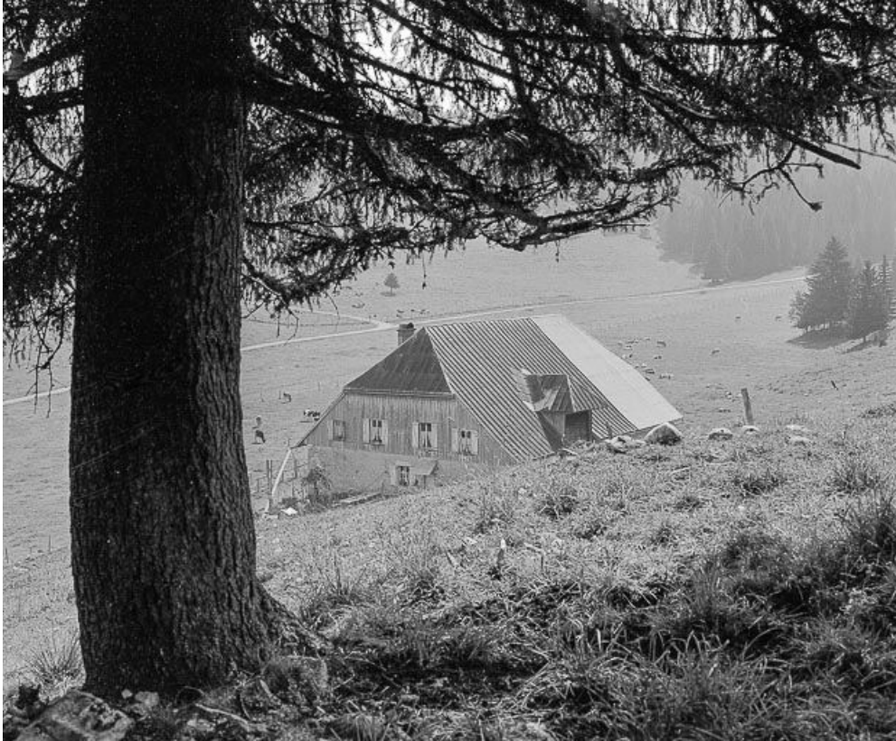
Pignon antérieur et goutterot droit.
