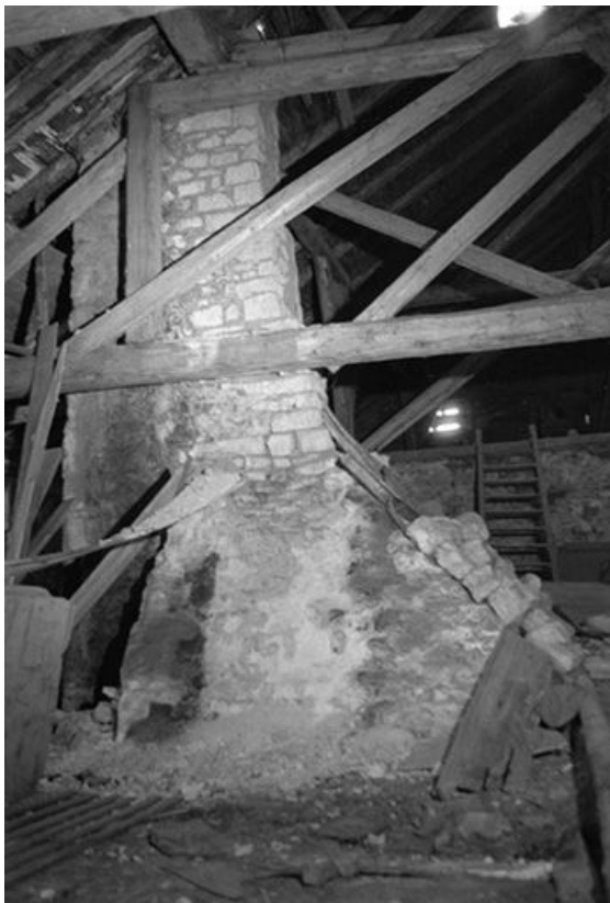
Intérieur : charpente et cheminée.
