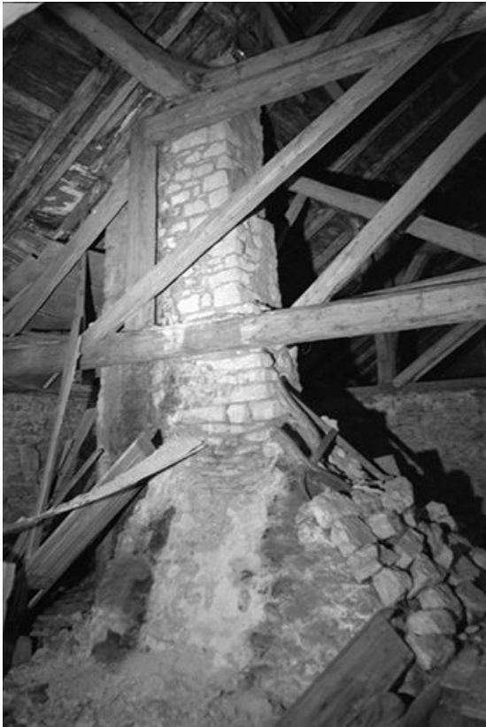
Intérieur : charpente et cheminée.
