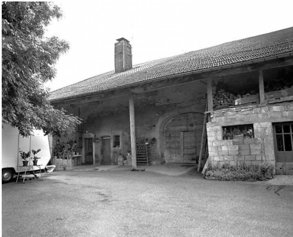
Détail du mur goutterot.
