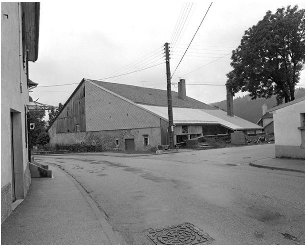
Pignon sur rue et goutterot.
